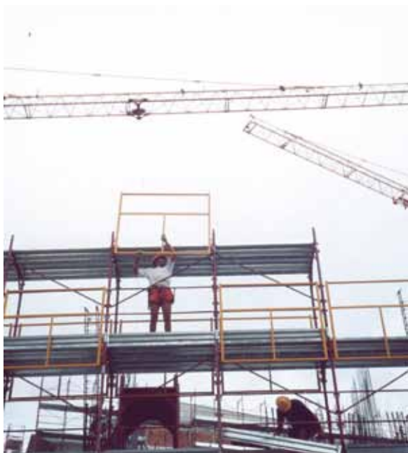
Foto 2. Montaggio del ponteggio a telai prefabbricati in sicurezza con parapetto provvisorio dal di sotto.
