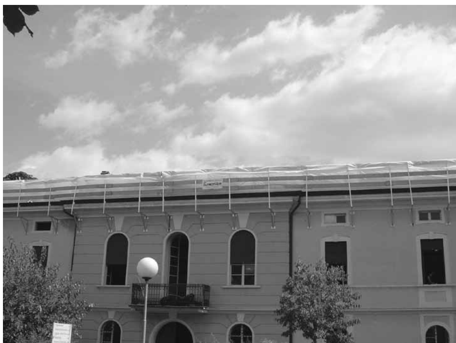
Sistemi provvisori di protezione bordi tetti
